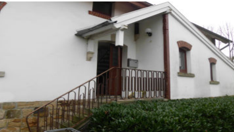
Der „Hintereingang“: vorher
