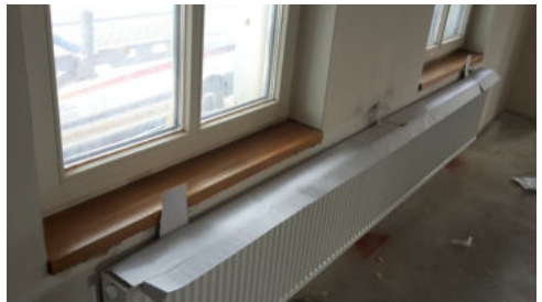
28. Mai - Heizungen, Fensterbänke...
