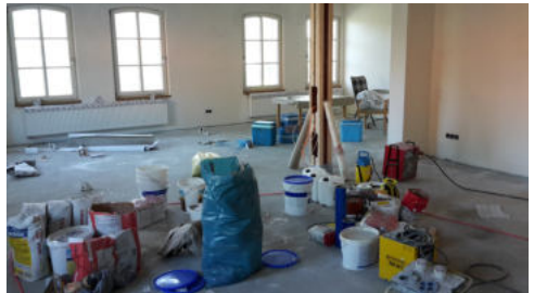
Noch viel Arbeit, aber es geht voran! Zur Zeit werden die Außenanlagen geplant...
