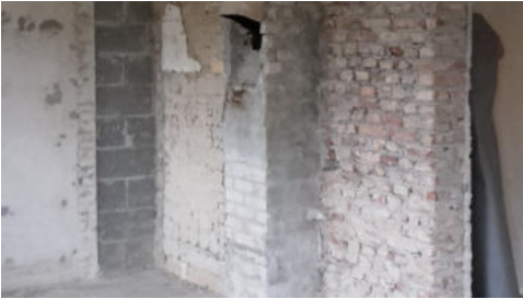
8. März - Der Kamin im Erdgeschoss ist fort. An seiner Stelle ist ein Kaminofen geplant.
